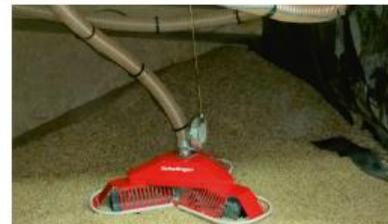
**Ziel:** Maulwurf E3 sitzt auf den Pellets. Schlauch verläuft in leichtem Bogen zur Decke.
