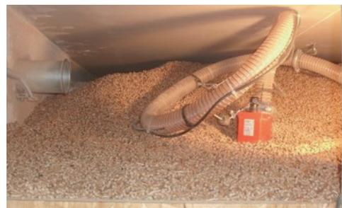
**Betriebsposition:** Der Schlauch verläuft in leichtem Bogen zur Decke. Der Maulwurf sitzt mit der Saugöffnung in Richtung Pelletberg (Typenschild zur Tür bzw. zum Betrachter). Das Gehäuse ist mindestens zur Hälfte mit Pellets überdeckt.
