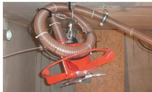
**Befüllposition:** Der Maulwurf befindet sich an der Decke. Der Schlauch verläuft kreisförmig an der Decke. Schlauch und Gerät dürfen nicht im Füllstrahl hängen.
