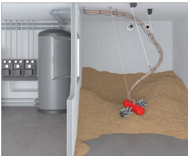
Abb. 22: Flachbodenlager mit Saugentnahme von oben
