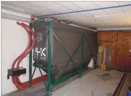
Abb. 10b: Trogsilo mit mehreren Saugentnahmepunkten
